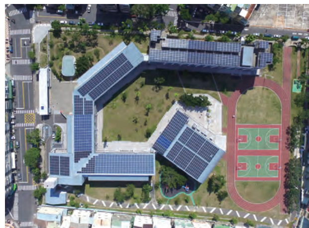
教育設施類建築： 樂群國民小學(306.36kwp)
