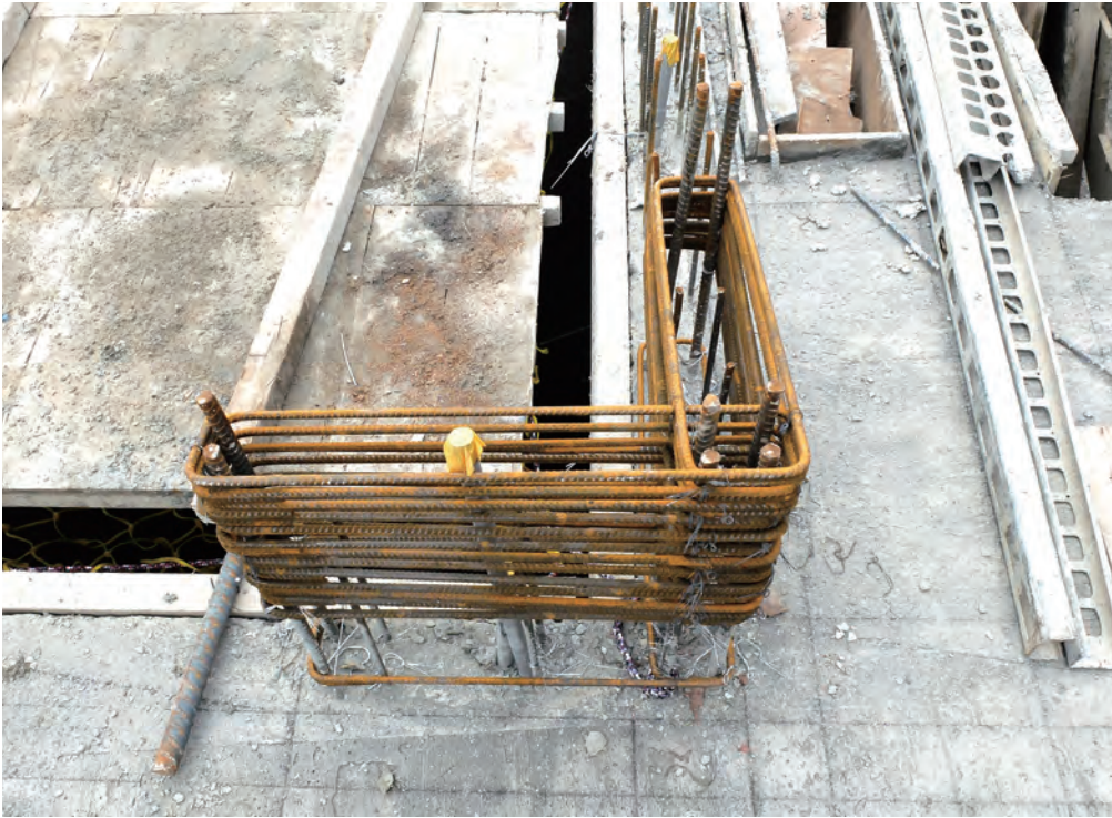
「Alfa Safe系統工法」—系統牆工法影片介紹
