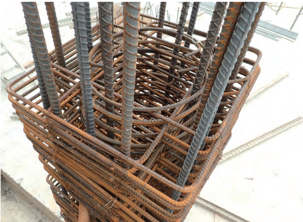
「Alfa Safe系統工法」—柱中柱工法影片介紹
