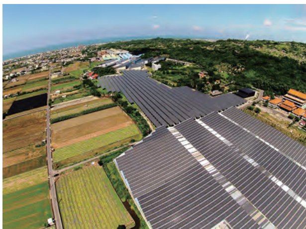
廠房設施類建築： 壹東實業股份有限公司(1,0000 kwp)
