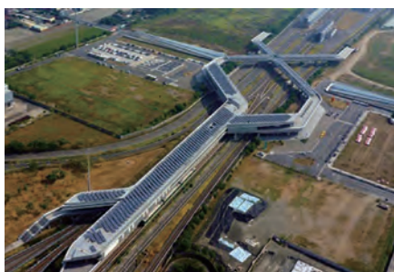
交通設施類建築： 高雄捷運_大寮捷運站(2605.17 kwp)
